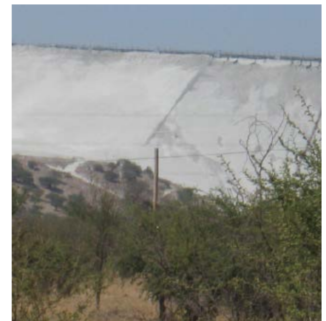
Figura 2. Tranque de relaves Las Tórtolas, de Minera Angloamericana, donde se observa la fractura y el hundimiento parcial de su muro de contención después del sismo de febrero de 2010. Reproducido de Tchernitchin y Muñoz (2012: 199).
