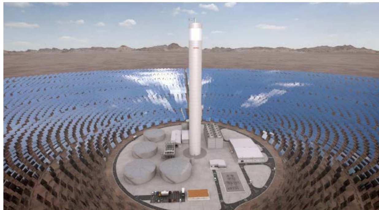
Planta de Concentración Solar de Abengoa, en el Desierto de Atacama con una torre de 250 metros y 10.600 espejos heliostatos (Gentileza de Empresa Abengoa, España).
